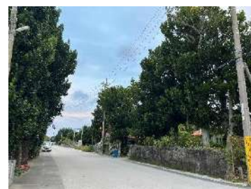
写真 1-4 集落内で整備された透水性舗装
