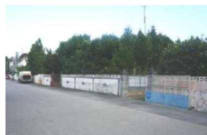
写真 1-5 実施された石張りや塗装の状況
